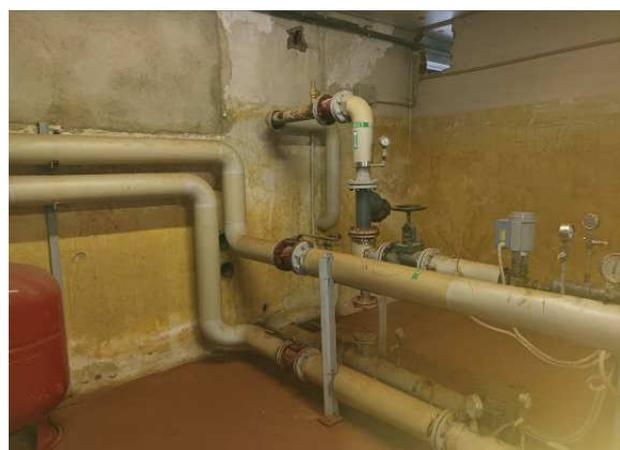
Elementi in centrale termica oggetto di sostituzione: bollitore, gruppi di pompaggio, vasi di espansione, condotte di distribuzione con isolamento termico
