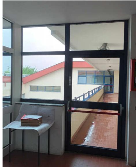
Infissi oggetto di sostituzione con installazione di sopra luce opachi
