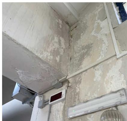
*Zone oggetto di distacco dell'intonaco e formazione di muffe*
