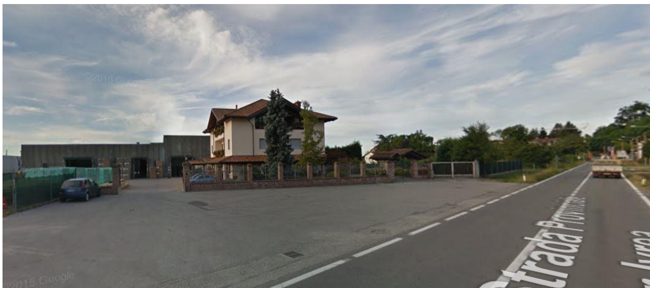
Vista della proprietà con gli accessi proveniendo da Ivrea verso Castellamonte.
