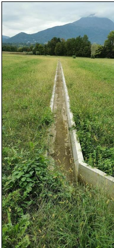
*Figura 20. Foto 9 – Canaletta in c.a. che crea interferenza con il tracciato.*
